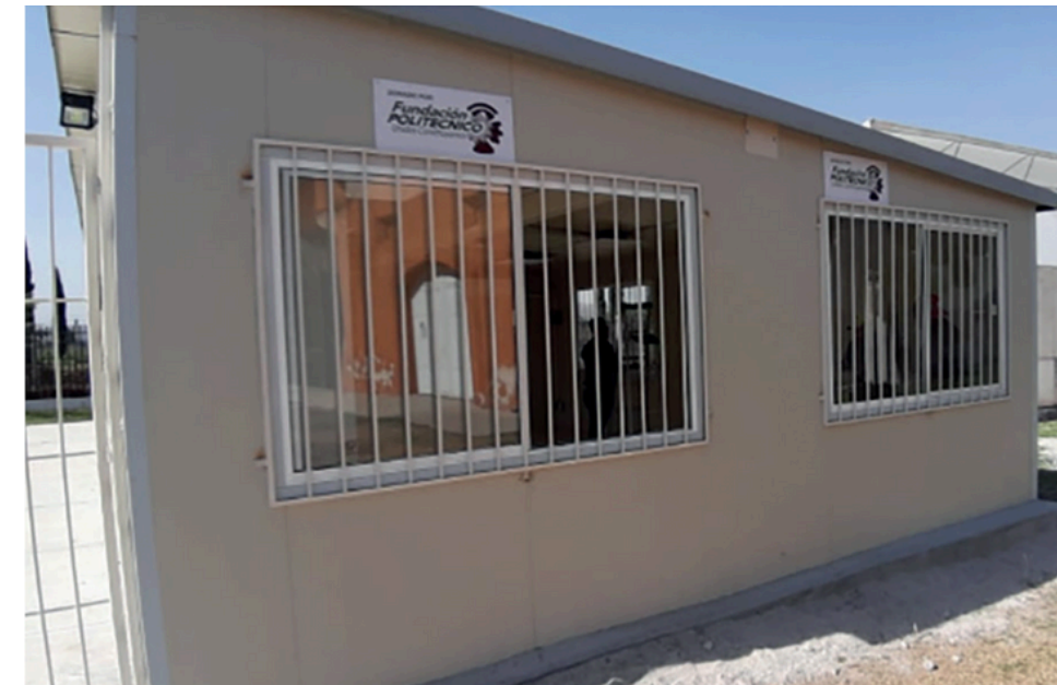
Colocación de "Aulas Fundación" (casetas prefabricadas equipadas).
