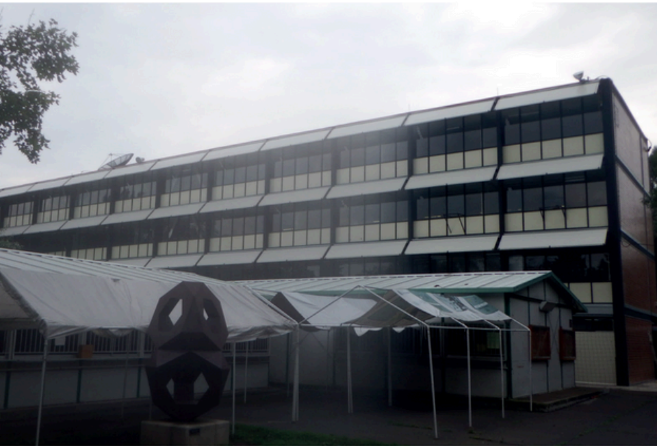
Renovación Integral del edificio 1 ESIME Zacatenco
