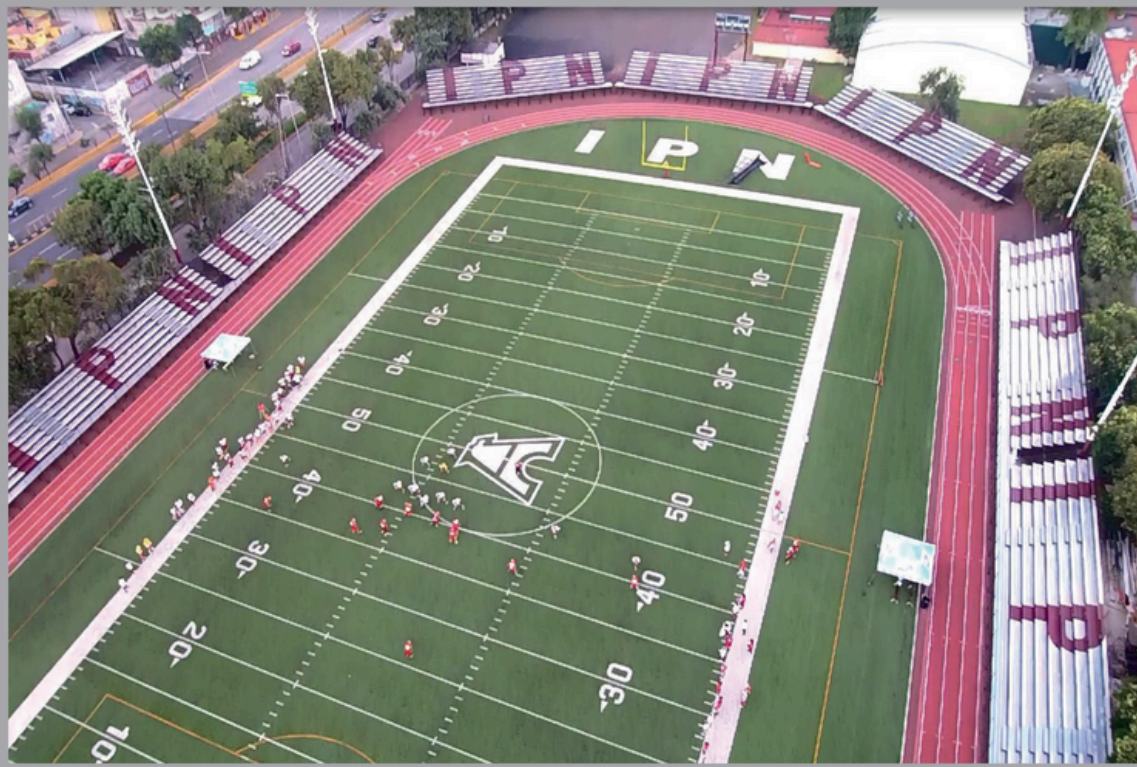
Renovación de estadio “Águilas Blancas” y equipamiento.
